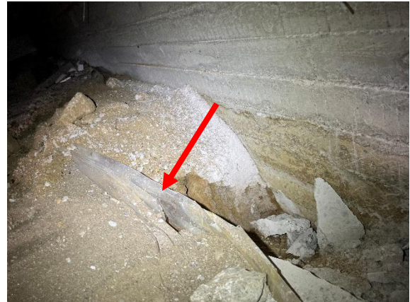
Kuva 11. Vähintäänkin varaston alapohjatilassa on pinta-hiekan alla muovikalvo.
