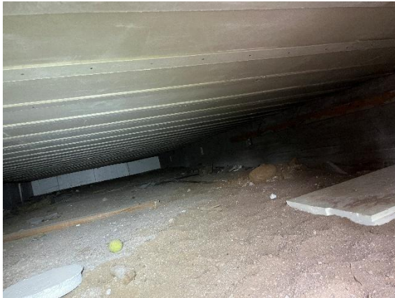
Kuva 10. Yleiskuvaa varaston alapohjatilasta.
