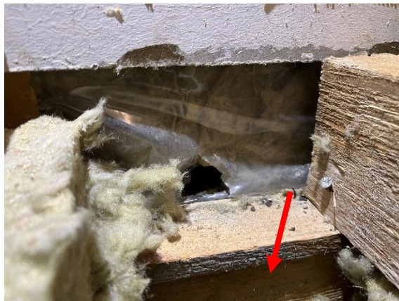
Kuva 38. Yleiskuva rakenneavauksesta. Nuolella osoitettu M2 näytteenottoaika.
