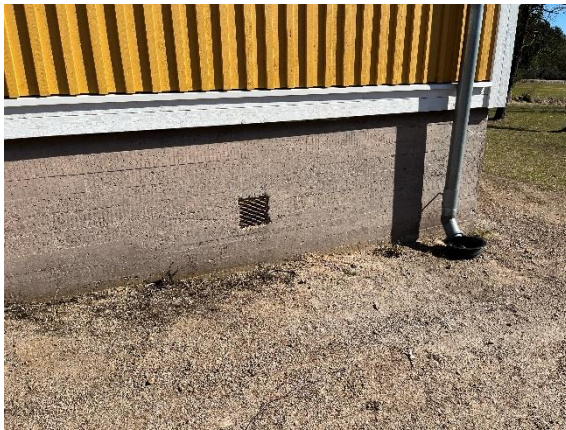
Kuva 6. Korvausilmaluukku.
