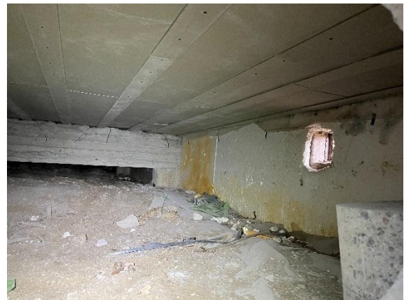
Kuva 13. Yleiskuvaa liikuntasalin alapohjatilasta.
