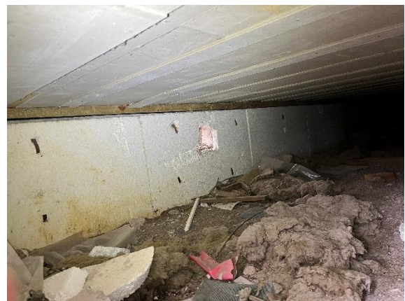
Kuva 9. Alapohjatilassa on muun muassa mineraalivillaa. Kuva varaston alapohjatilasta.
