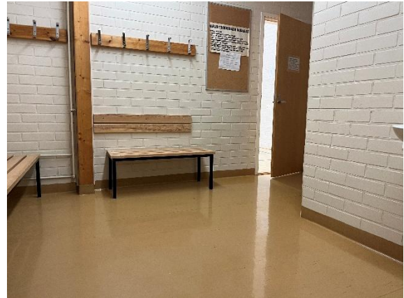
Kuva 17. Yleiskuvaa pukuhuoneiden muovimatoista.
