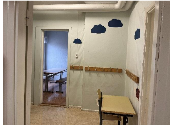
Kuva 42. Yleiskuva toisesta kerroksesta.
