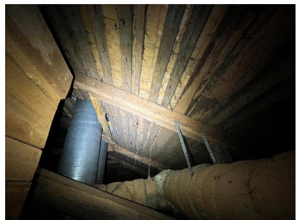
Kuva 63. Harvalaudoituksen päällä on umpilaudoituus.
