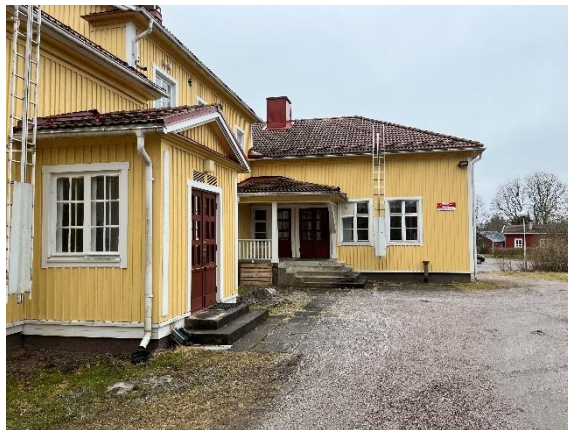
Kuva 60. Vesikate on likaantunut.
