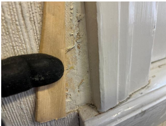
Kuva 32. Ikkunaa on massattu.
