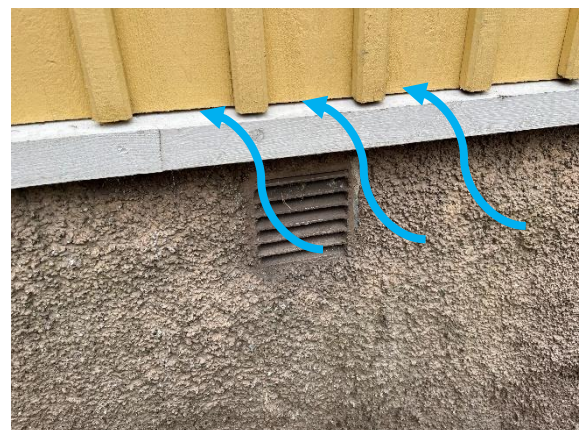
Kuva 17. Julkisivun alla on vähäinen tuuletusrako.
