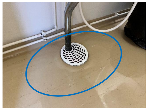
Kuva 46. Molemmissa vessoissa osoitetulla alueella muovimatto on irti alustastaan.
