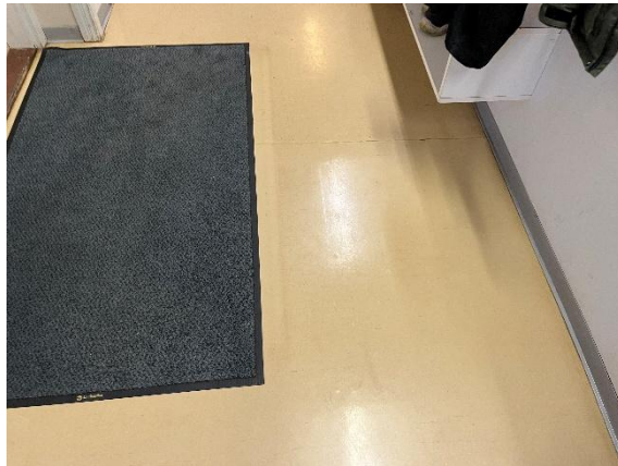
Kuva 37. Yleiskuva ensimmäisen kerroksen muovimatosta.
