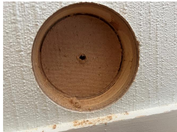
Kuva 30. Yleiskuva rakennekerroksista.
