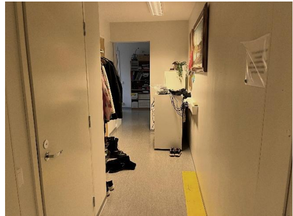
Kuva 38. Yleiskuva ensimmäisen kerroksen uusitusta muovimatosta.
