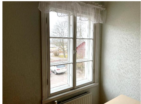
Kuva 21. Yleiskuva toisen kerroksen ikkunasta.
