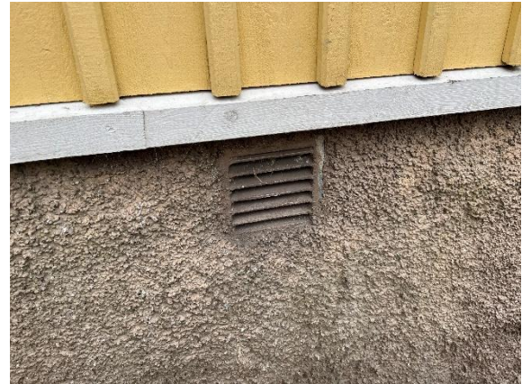
Kuva 7. Yleiskuva sokkelissa olevasta korvausilmaventtiilistä.
