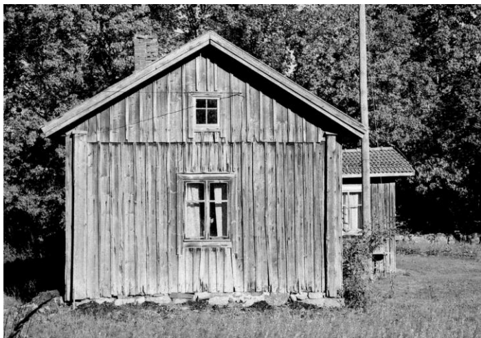
Pystylaudoin ja rimoin vuorattu vanha hirsirakennus Untamalassa. Nurkat koteloitu ja lautojen jatkosauma räystään tasolla. Untamalan hirsirakennuksista ainoastaan Sarkin talo on vuoraamaton
