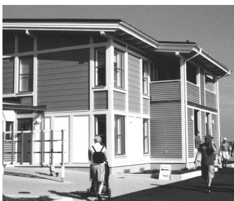
Kenttiin jaettu julkisivu vuoden 2004 asunomessutalossa. Jakolistoista ja kenttien laudoituksesta puuttuu kuitenkin se tyylikkyys, mikä on tunnusmerkillistä vanhoille rakennuksille. Suurin syy tähän on, ettei nykyinen puutavara ole yhtä tiivistä ja kovaa kuin ennen ja listoista on tehtävä tuntuvasti paksumpia, jotta ne kestäisivät ulkona.
