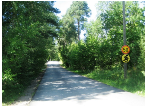
Karjalantie on kapea, leveydeltään vain n. 3,5 – 4 m. Tie on päällystetty asuinalueen kohdalta, muualla se on hiekkatie. Pähkinäpensaat sekä muu puusto rajautuvat paikoitellen aivan tien reunaan.
