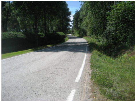
Salontie on 6 m leveä päällystetty tie ilman maalattua keskiviivaa.
