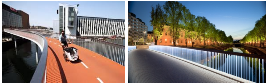
Kuva 1. (vasemmalla): Sillan dynaamisella muodolla ja kulkuväylän pinnoitteen lämpimällä värisävyllä saadaan aikaan sekä moderni että lämmin vaikutelma (Bicycle snake, Kööpenhamina Dissing+Weitling Architecture). Kuva 2. (oikealla): Turun kirjastosilta (Pontek Oy) valaistus on toteutettu siltakaiteen rakenteeseen, alaspäin suuntautuva valo korostaa siltakannen pintaa, luo rikkaan vaikutelman sekä aikaansaa jalankulkijalle miellyttävän mittakaavan. Kuva Vesa Aaltonen/turku.fi.
