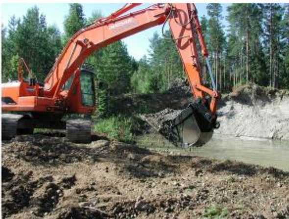
Kuvat 3. ja 4. Lammikoiden pohjat ruopattiin ja eloperäinen aines poistettiin kaikilta täytettäviltä alueilta. Ruoppauksen jälkeen lammikot ja kosteikot täytettiin puhtaalla harjusoralla.
