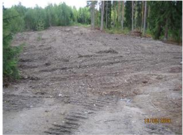
Kuvat 8., 9. ja 10. Maastonmuotoilussa hyödynnettiin rinnehuiskista saatavaa materiaalia. Alueen omat pintamaat riittivät ohueksi kerrokseksi koko alueelle. Jo ensimmäisenä kesänä käsitellyt alueet saivat tiiviin kasvillisuuspeiton.
