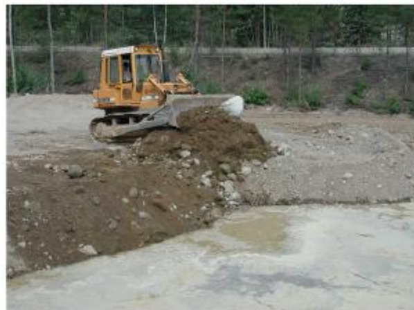
Kuvat 3. ja 4. Lammikoiden pohjat ruopattiin ja eloperäinen aines poistettiin kaikilta täytettäviltä alueilta. Ruoppauksen jälkeen lammikot ja kosteikot täytettiin puhtaalla harjusoralla.
