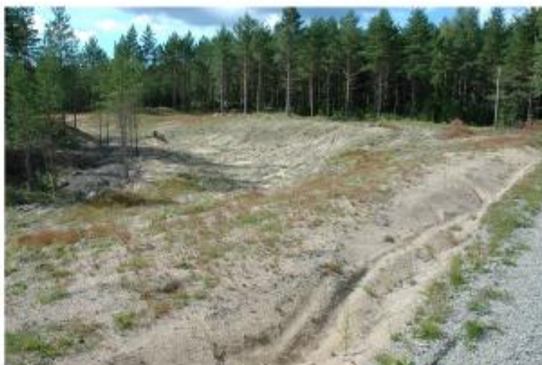
Kuvat 5., 6. ja 7. Tien vierellä olevia rinteitä loivennettiin täyttämällä ja luiskaamalla.
